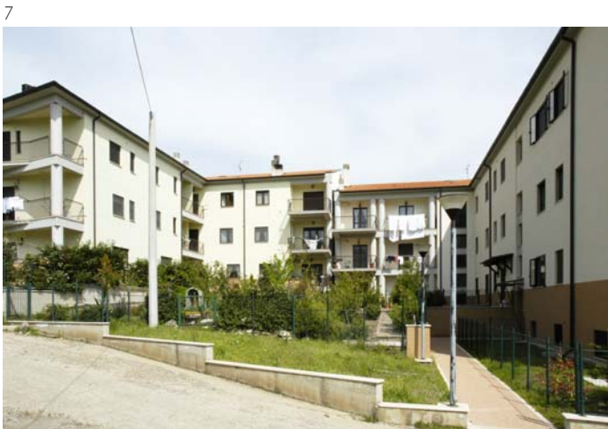
Abitazioni in Via Monticchio 5, fronte est, loggia dell'edificio C 6, fronte est, dettaglio dell'edificio B 7, fronte ovest, corte tra gli edifici D, C, E 8, fronte ovest, edifici E, C, B
